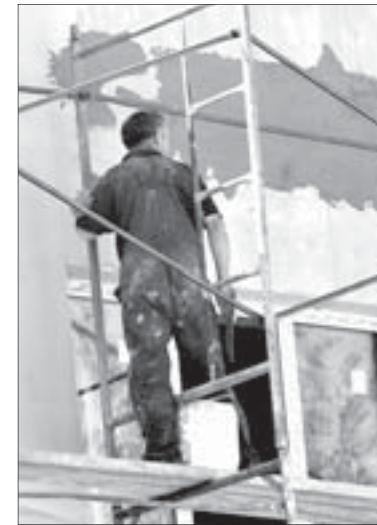
Дом для детей-сирот и детей, оставшихся без попечения родителей, возводит нижнетагильская компания «Ресурс». Строители заканчивают работы на внешних коммуникациях, ведут внутреннюю отделку, начали заниматься фасадом
