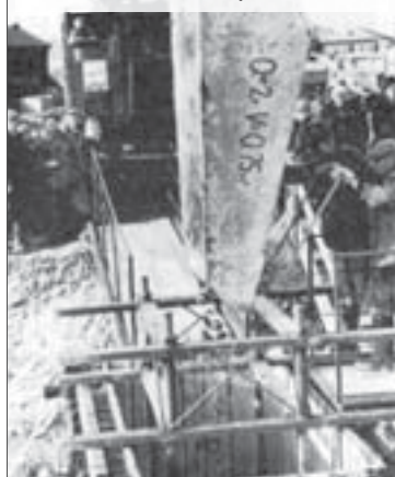
Закладка первого фундамента под опорную колонну горячей части ТПЦ-1. 2 ноября 1967 года
