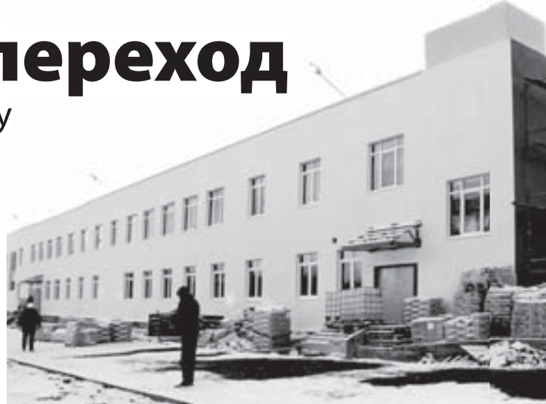
Работы по подключению объекта к инженерным сетям завершены
