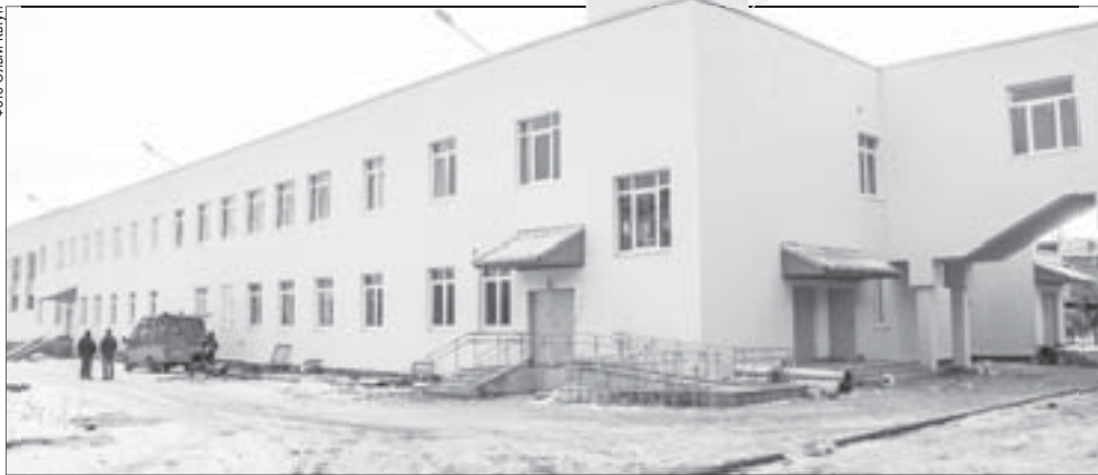
Приёмка пристроя к школе № 14 состоится 18 декабря. Полезная площадь нового капитального здания составила 4220 квадратных метров
