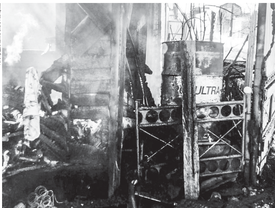
На площади 58 квадратных метров сгорела кровля, потолочное перекрытие, домашнее имущество и стены садового дома, повреждены автомобили «ВАЗ-2109» и «Приора»
