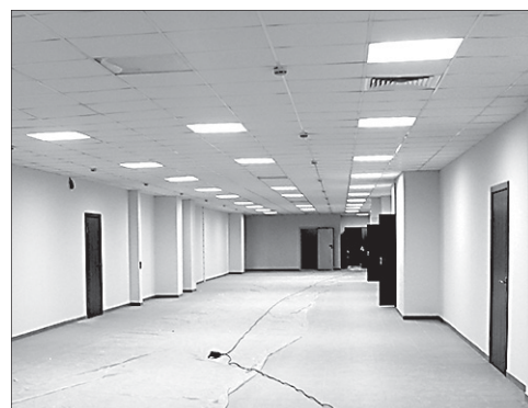
Чтобы школа прошла проверку надзорных органов, необходимо перекрасить стены
