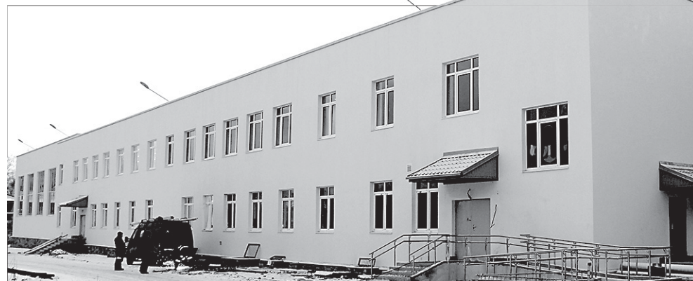
Строительство пристроя и его оборудование федеральному, областному и муниципальному бюджетам обошлось более чем в 100 миллионов рублей
