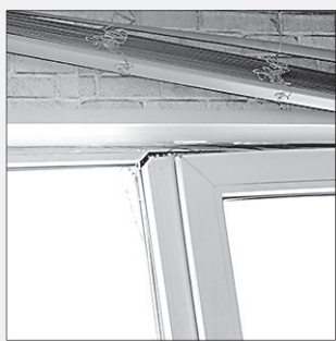
Лопнула пластиковая рама, стекло треснуло
