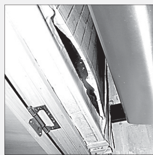
От влаги деформировалась обшивка стен
