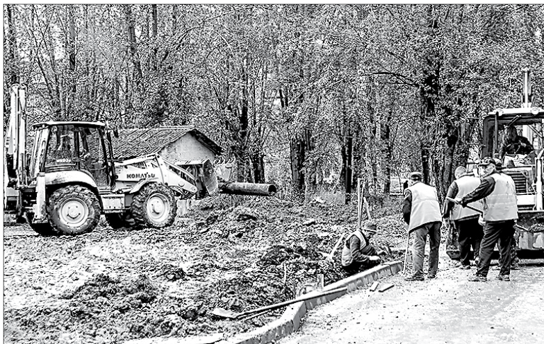
Ремонт тепловых сетей в южной части города
