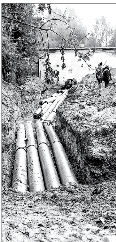
Ремонт тепловых сетей
