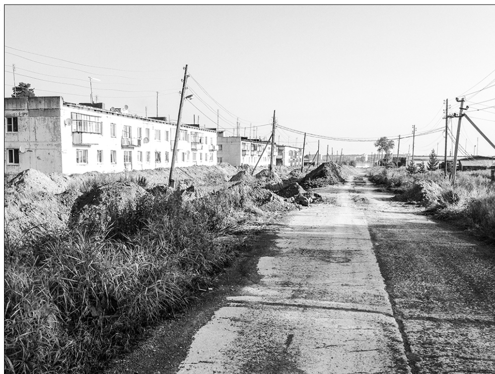
На улице Садовая меняют сети холодного и горячего водоснабжения и построят новые
