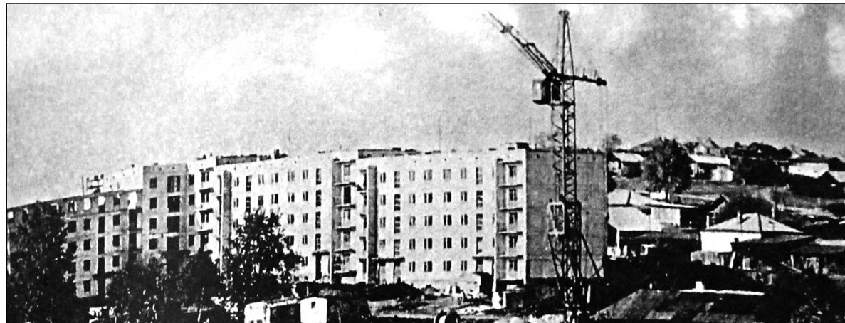
Строительство домов в Ялунинском микрорайоне, 1980-е годы. Вид с улицы Григорьева
