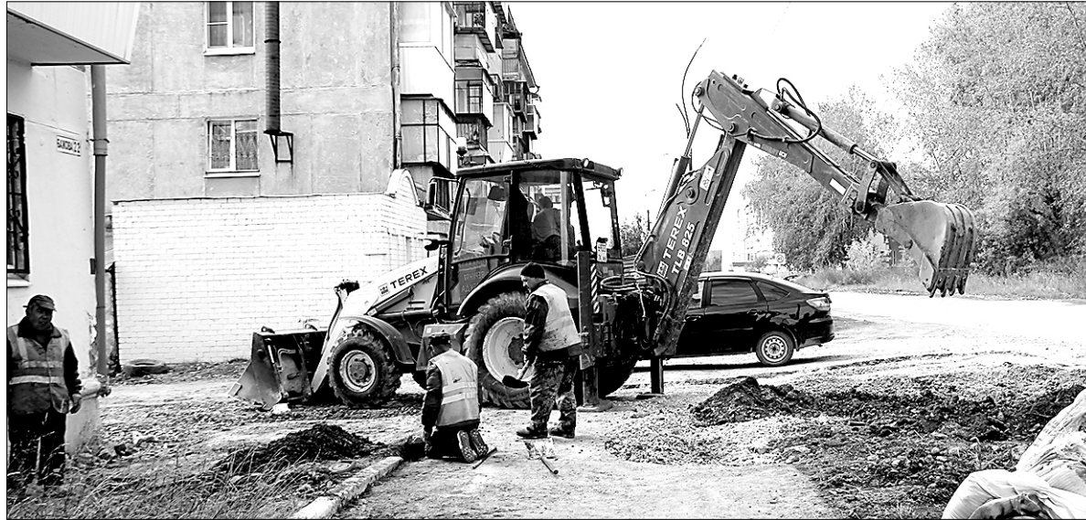
На замену водопроводных сетей в южной части летом затрачено 32 миллиона рублей. На фото бригада рабочих ремонтирует сети на улице Бажова
