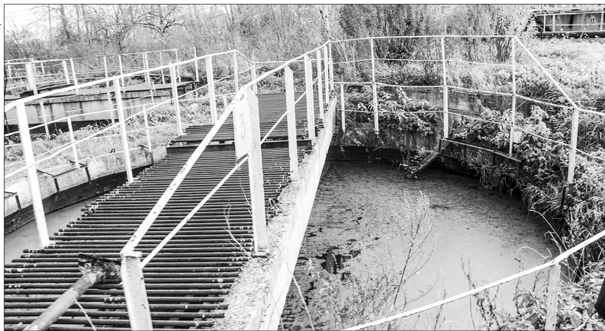
Сегодня в работе четыре отстойника-пескоуловителя, двум из них необходим ремонт
