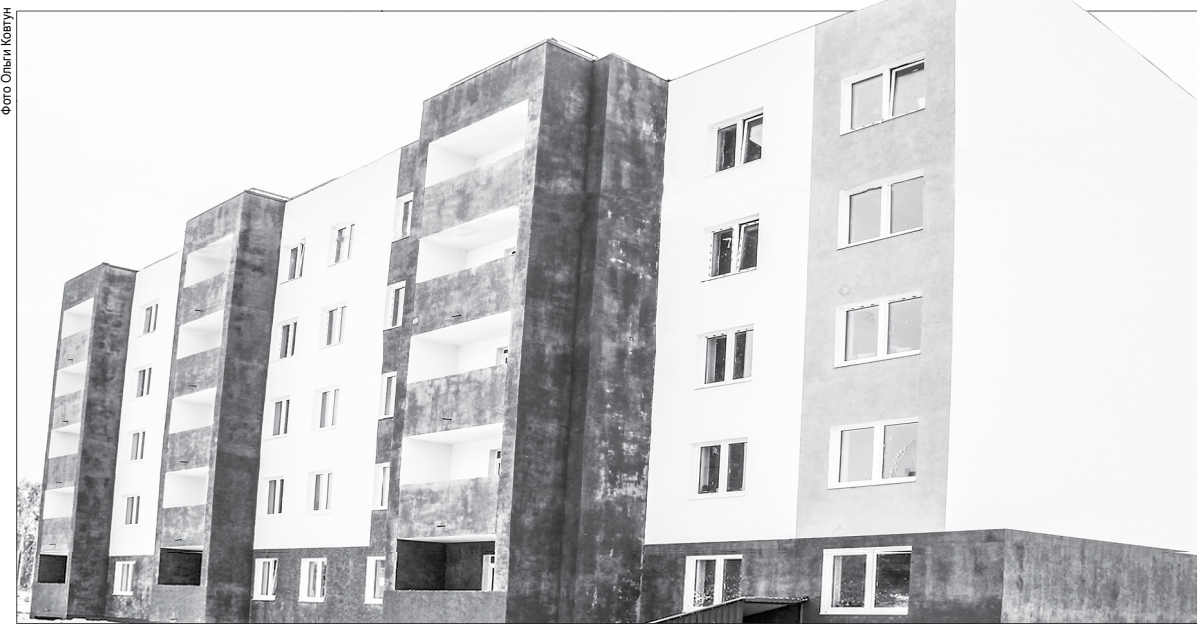
Строительство пятиэтажного многоквартирного дома на улице Розы Люксембург близится к завершению. Выполнены основные строительные работы, сейчас идёт чистовая отделка комнат
