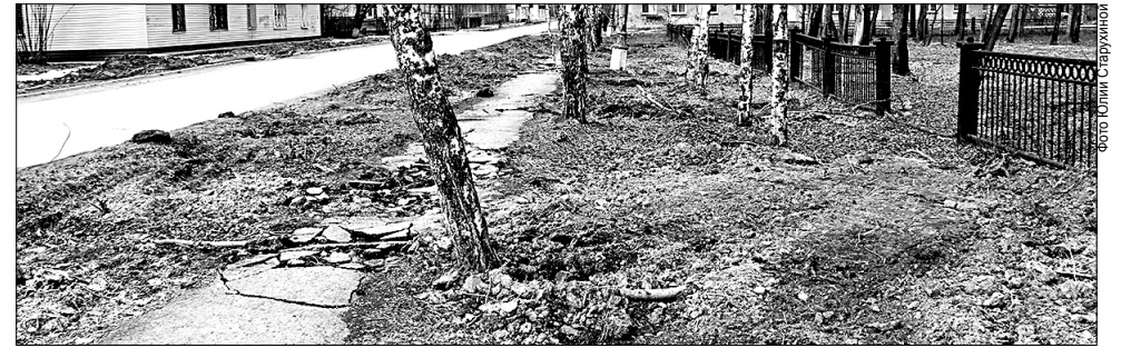
На улице Победы накануне работ по благоустройству проложили участки нового питьевого водовода
