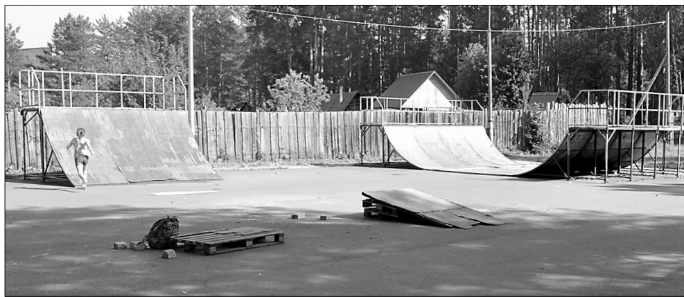
Скейт-площадка на территории городского парка сейчас находится в полуразрушенном состоянии
