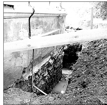
Дождевая вода заполняет вырытые траншеи и мешает ремонту фундамента
