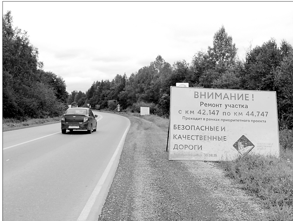
Ремонт двух участков Полевского тракта выполняет компания «Уралдорстрой»
