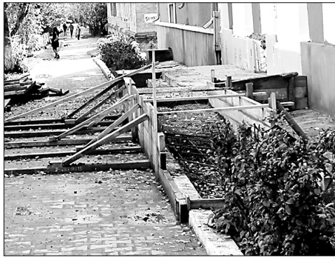
После установки пандуса маломобильные граждане смогут беспрепятственно посещать здание администрации
