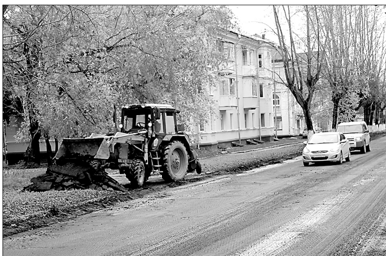
На улице Ленина сняли старый асфальт, в ближайшее время начнут укладывать два слоя нового полотна
