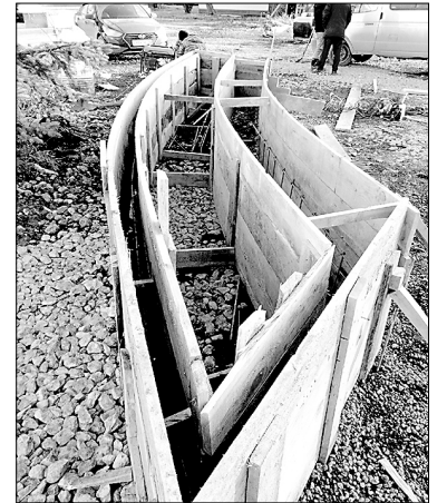
Готовится опалубка под фундамент декоративной клумбы со скамейкой
