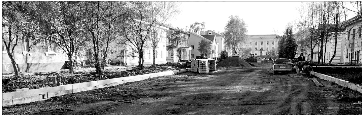
Новый облик улицы Трояна уже просматривается. Общая площадь, которая попала в зону реконструкции, составляет более 7 тысяч квадратных метров
