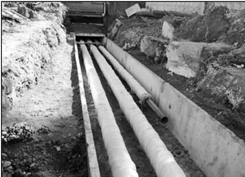
На ул. Гробова, 27-29, был заменен участок трубопровода, а также проведена замена запорной арматуры, установка затворов. И это лишь часть проведенных работ.
