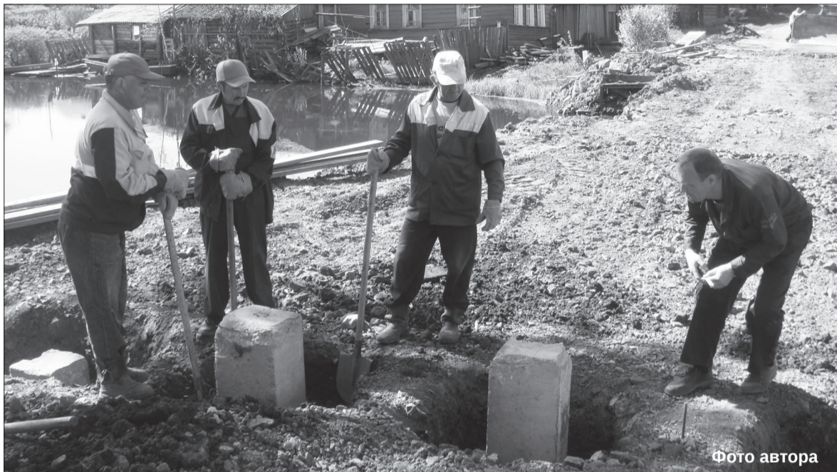
Идет подготовительная работа перед забиванием свай
