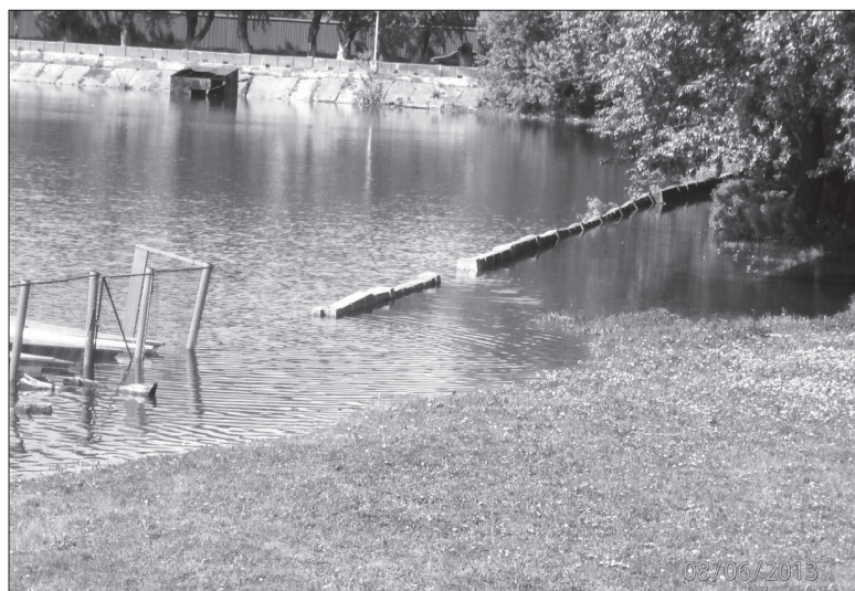
Набережная ушла под воду
