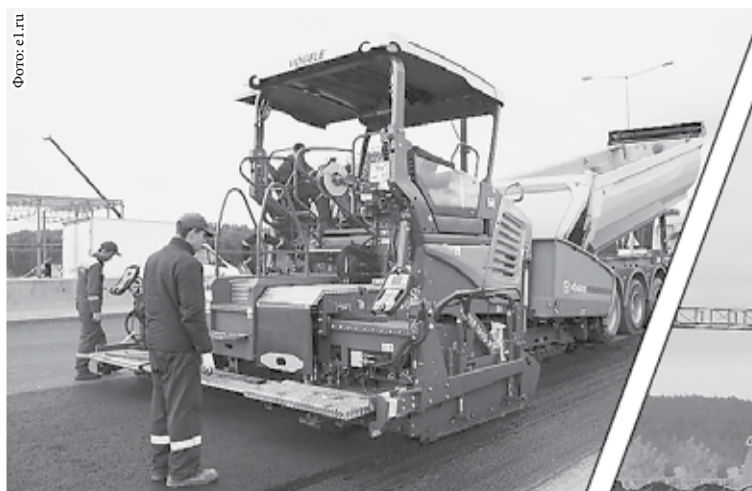
По итогам года после ремонта и капремонта планируется ввести в эксплуатацию 124 км автодорог
