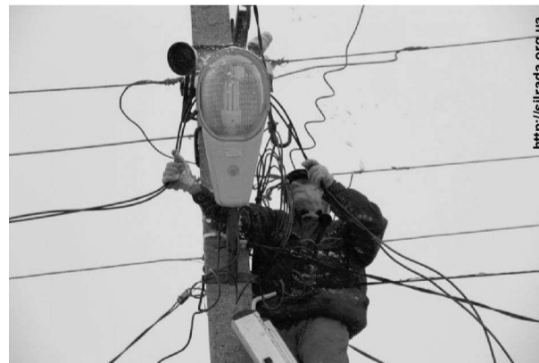
Ремонтно-восстановительные работы продолжались весь день
