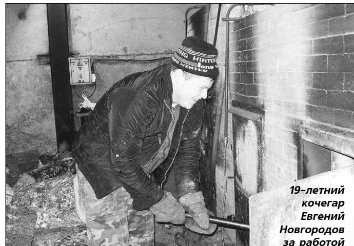
**Н**ОВИНКА напоминает собой простую русскую печь, сложенную из обычного кирпича. Только топка не одна, а три, в них ярким пламенем полыхают дрова. Через каждый час кочегары, а их двое, затапливают в печку неровные, искореженные останки древесины, не давая погаснуть огню. Процесс бесперебойный и довольно хлопотный.
