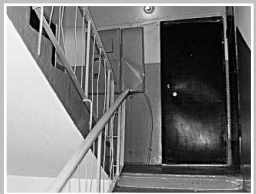
В подъездах жилых домов
