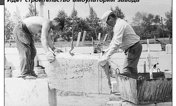
Идет строительство амбулатории завода
