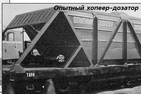
Опытный хопеер-дозатор
