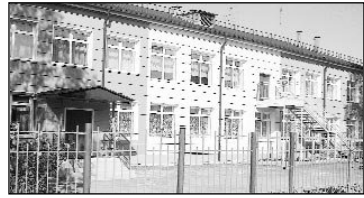
ГЛАВНЫМ событием года явилось открытие обновленного в ходе реконструкции детского сада № 18 "Березка", которому в 2013-м исполнилось 50.
