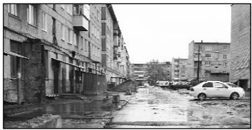
ЗААСФАЛЬТИРОВАНЫ дороги во дворах домов по ул. Коммуны, 49, 51, 51-а, и вдоль "китайской стены" - от ул. Красноармейской до почты.
