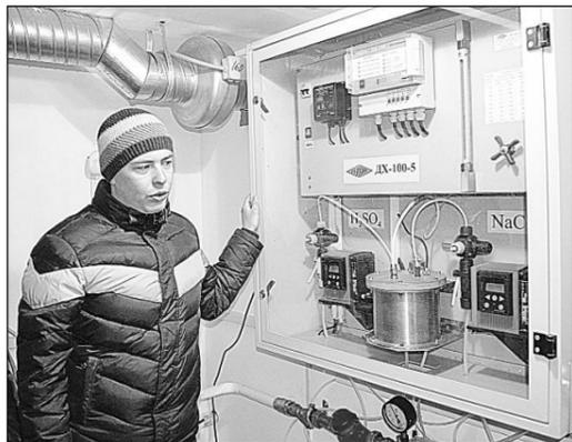
**ЧИСТАЯ** вода для здоровья человека – первоочередная необходимость для его жизнедеятельности. До последнего времени хлорирование воды было едва ли не единственным методом ее обеззараживания на водоочистных сооружениях, обеспечивающим стойкий и достаточно длительный эффект обеззараживания. Однако исследования, проведенные в последние
