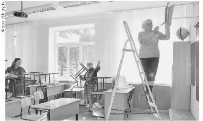
Впереди – ремонт школ.
