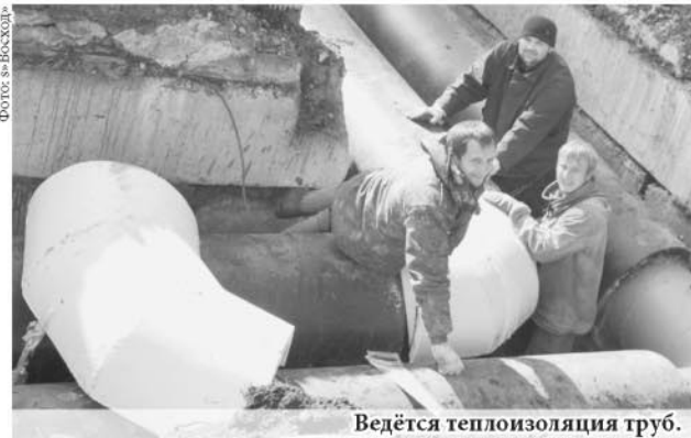
Ведётся теплоизоляция труб.
