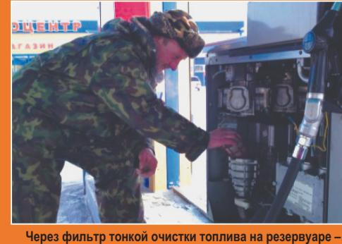
Через фильтр тонкой очистки топлива на резервуаре – наше ноу-хау – бензин поступает на входной фильтр ТРК и, наконец (!), через пистолет, в котором также установлен фильтр из мелкой сеточки, заливается в бак Вашего автомобиля.
