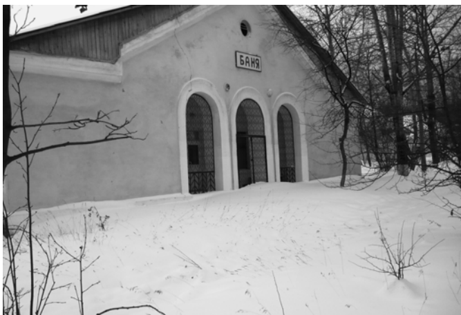
НА ФОТО: Занесенное снегом здание поселковой бани
