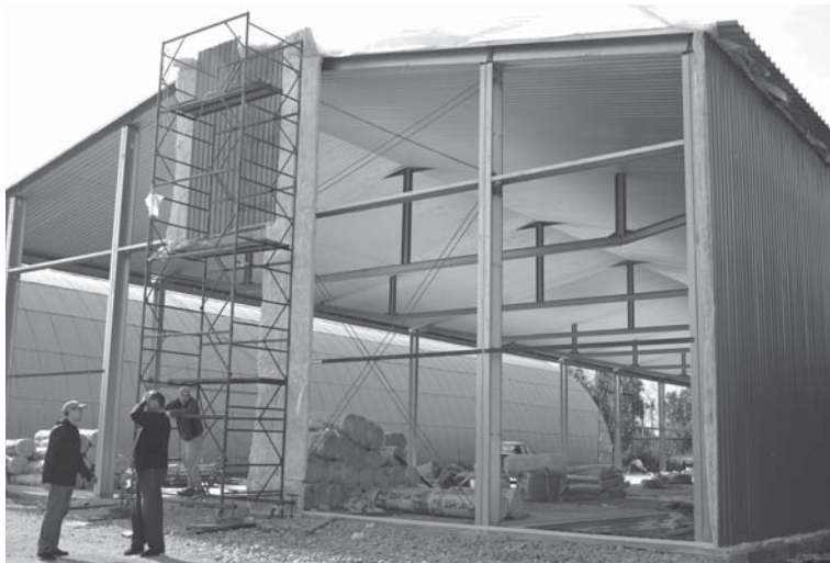
Новое хранилище уже на подходе
