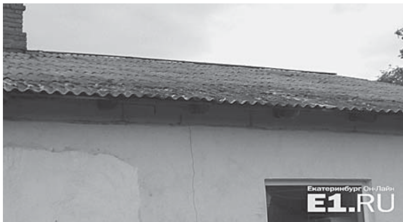
Детский сад до ремонта
