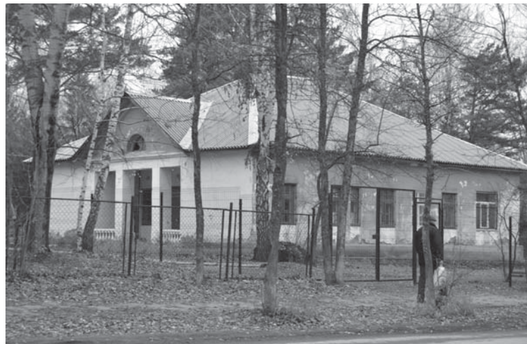
Школа искусств нуждается в ремонте
