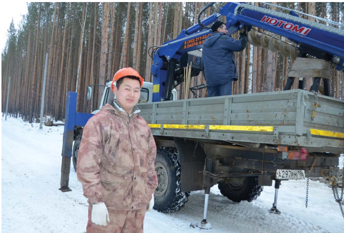
Монтируют опоры линии электропередач в «Родных просторах». Электромонтажник Эмиль Фаткулин
