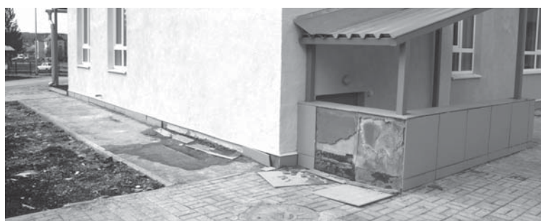
Патруши. Отвалилась фасадная плитка и облупилась штукатурка
