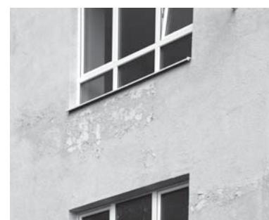
Патруши. Отвалилась фасадная плитка и облупилась штукатурка
