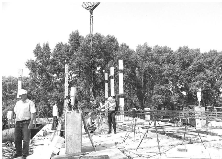
Активно ведется строительство жилой девятиэтажки на улице Кунавина. Бригада строителей ООО «УралЭнерго-инжиниринг» готовится к монтажу каркаса второго этажа.
