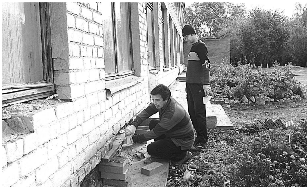
Строители ЗАО «РосИнтерСтрой» ведут подготовку к ремонту фасада Троицкой школы.
