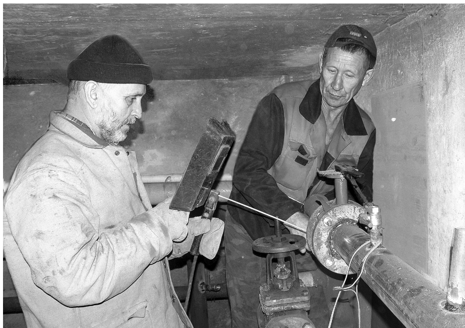
Работники ЗАО «ПМК-2» С.И. Клементьев и Н.В. Четвериков проводят ревизию отопительной системы.
