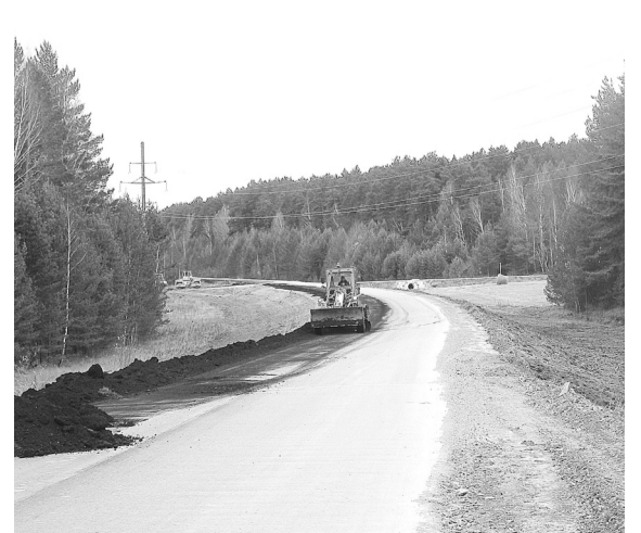
Заканчивается ремонт дороги в Кунарское.
