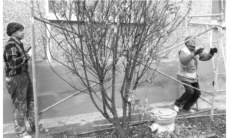
Работники ООО «Технологическая компания» С.В. Петров и А.А. Мартышев монтируют строительные леса на Ст. Щипачева, 47.
