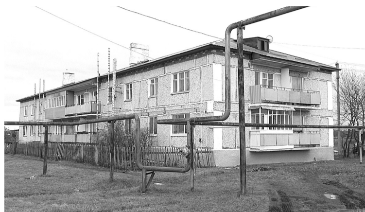
Дом N 1 на ул. Ленина в этом году отремонтирован по 185-ФЗ.
