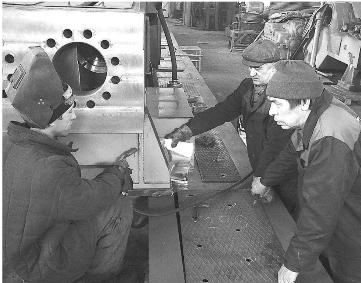
Монтаж насоса НБТ-1200L ведут работники «Уральского машиностроительного завода» Д.В. Андреев, А.И. Шведа и В.Б. Ощепков.
