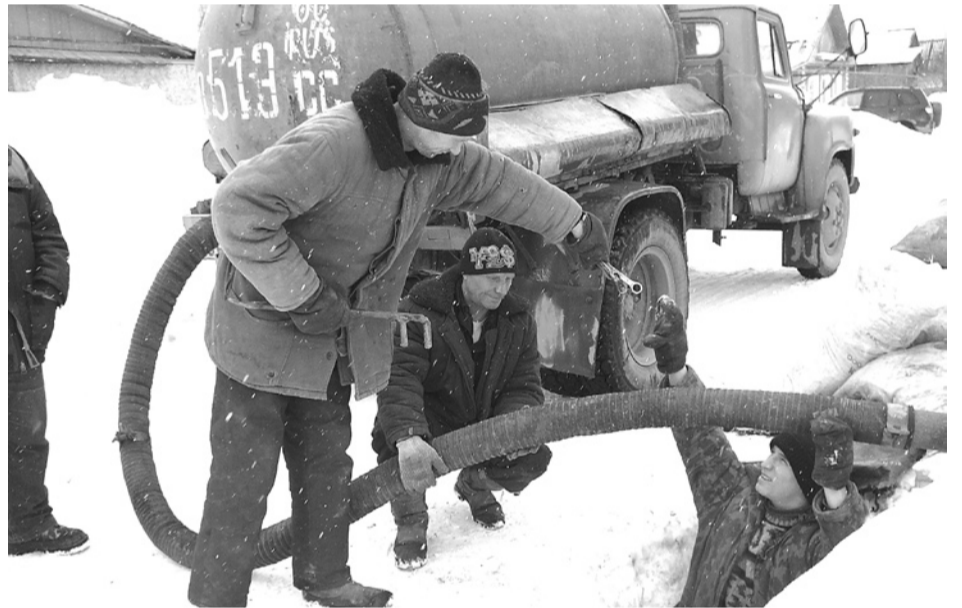
Обогревом колодца ХВС занимаются работники ООО «Водоканал» О.В. Пургин, В.А. Смирнов и А.А. Демин.
