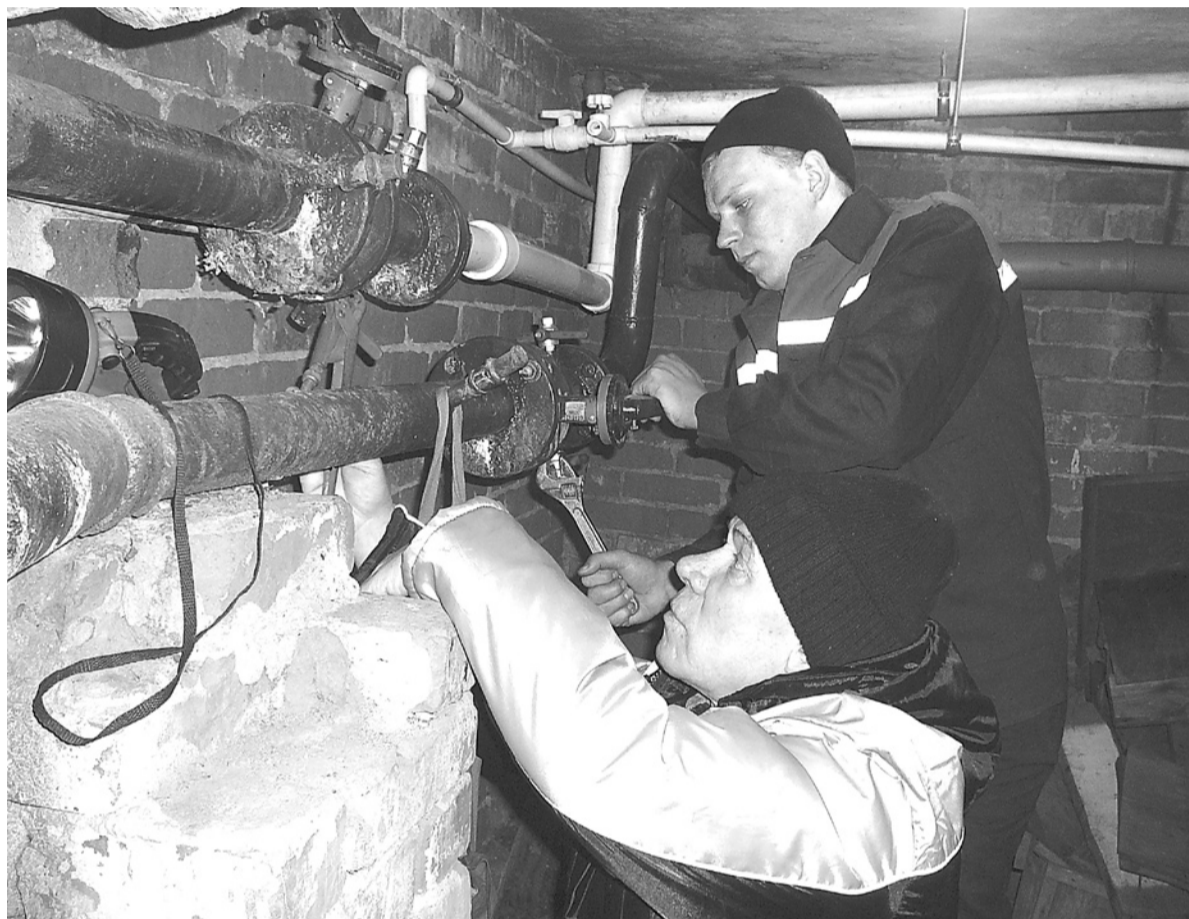
Протяжку задвижек в доме N 4 на ул. Ленина выполняют слесари-сантехники ООО «Управдом» В.Д. Гашков и К.В. Корольков.
