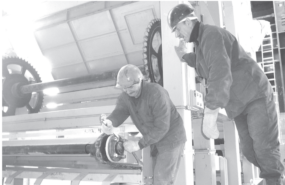
Монтаж камеры волоконнооплетения ведут работники «Атомстройкомплекса» С.В. Брусницын и С.С. Копутенко.
