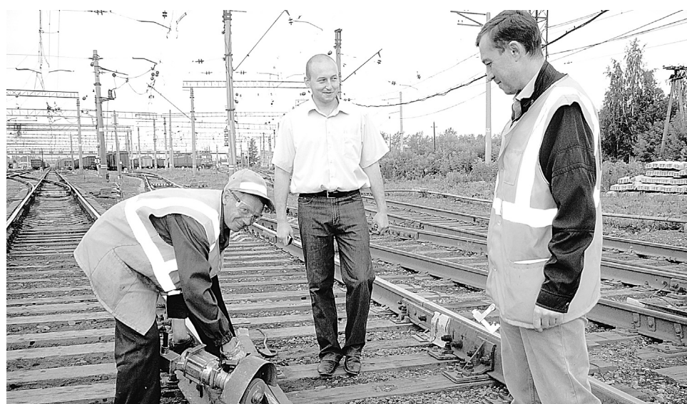
Е.О. Фоминых и мастер дорожного пути А.В. Кузнецов контролируют ход шлифовки стрелочного перевода, которую осуществляет монтер пути А.Г. Головин.
