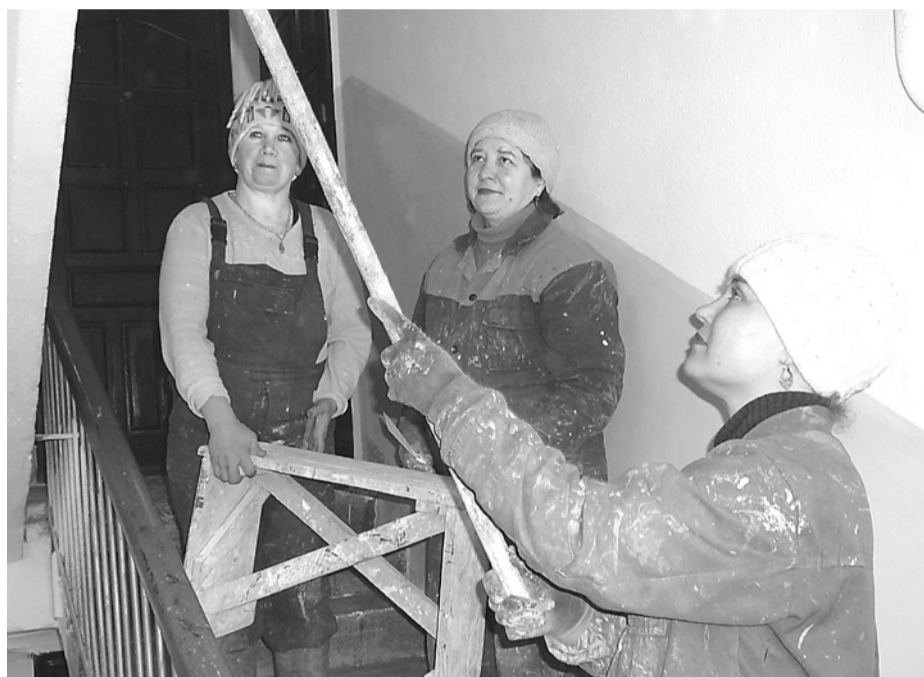
Отделочники ООО «Жилье» В.В. Валова, В.А. Шурманова и Т.М. Гуртовая грунтуют под покраску стены подъезда № 2 на улице Октябрьской, 15.
