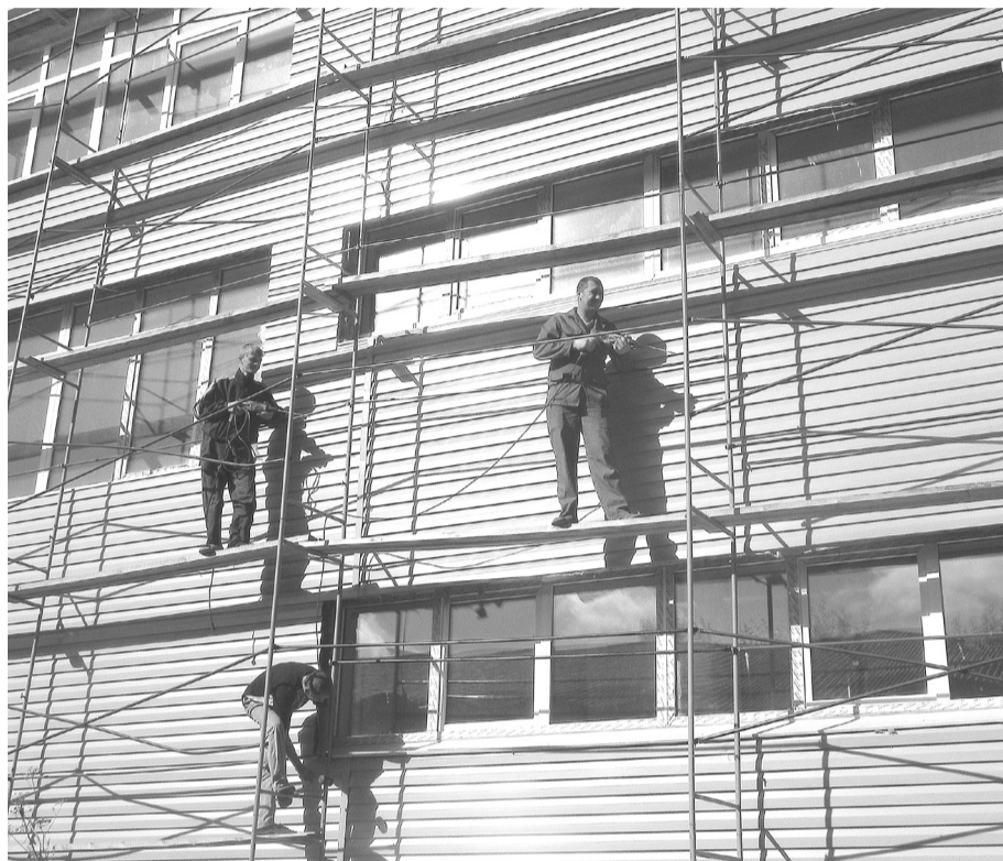
Строители ЗАО «Ремонтно-реставрационные работы» утепляют наружные стены здания школы № 4.
