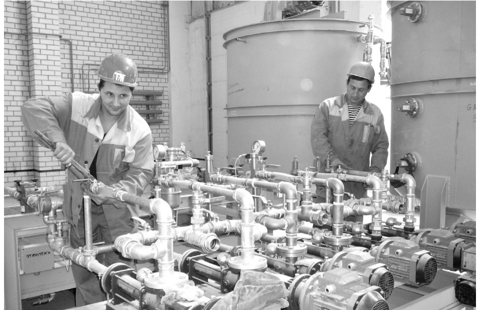
Монтаж насосного узла проводят рабочие «Атомстройкомплекса» В.В. Найданов и К.Г. Перепелица.
