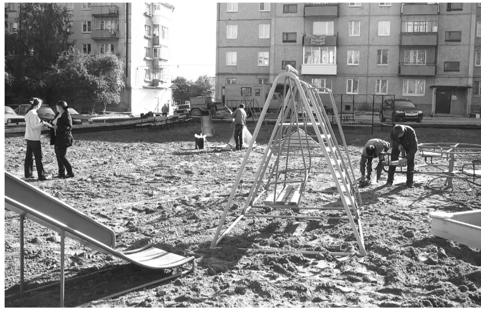
Благоустройство двора домов Октябрьская, 14, и Кунавина, 25, близится к завершению. Особенно активная работа развернулась здесь в минувшую субботу и воскресенье. За эти дни была обустроена детская площадка и уложена часть асфальта.
