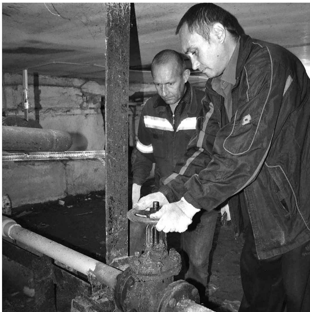
Вся запорная арматура в домах ООО «ПМК» прошла ревизию. На фото: ревизию узла системы отопления в доме № 39/1 на улице Степана Разина производят слесари Игорь Ильиных и Николай Рябцов.
