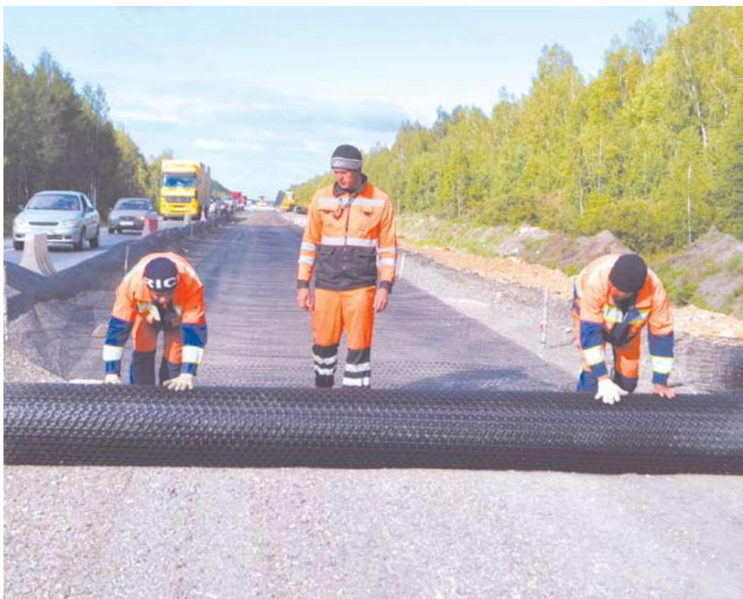
Ремонт дорожного полотна на Сибирском тракте ведется с укладкой пластиковой сетки (георешетки «Тенсар»), которая способствует повышению упругости полотна, препятствуя смещению и рассыпанию щебеночного слоя. На снимке: укладку решетки проводят работники ЗАО «Сибдорстрой» под контролем дорожного мастера Евгения Тельминова (в центре).
