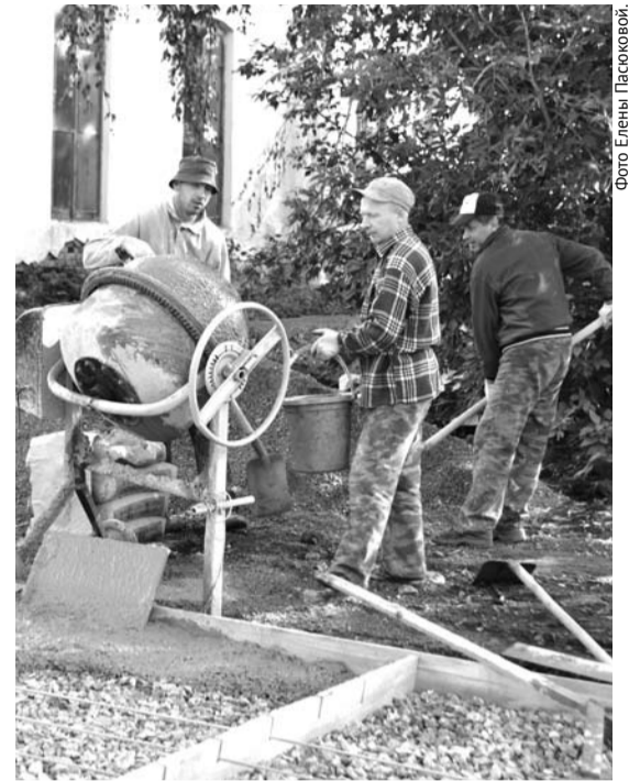
Заливку бетона у входа в новое пожарное депо ведут работники строительной организации ИП Арбузов С.Л.
